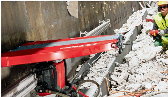
Equipo eléctrico DST 20-CA rebajando la altura de un muro de hormigón armado.
