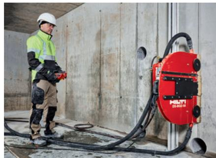
Corte de hormigón armado sin agua y con menos polvo gracias a la carcasa conectada a 2 aspiradores. Sólo para discos de 650mm (25,5 cm profundidad).
