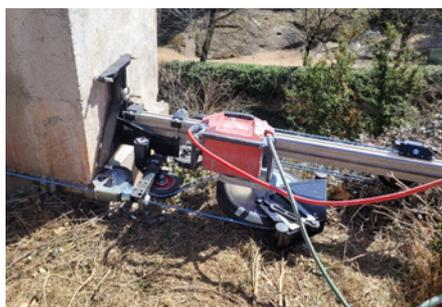
Multipoleas eléctrico DSW 2005 con la cabeza de sierra DST 20-CA cortando un pilar.
