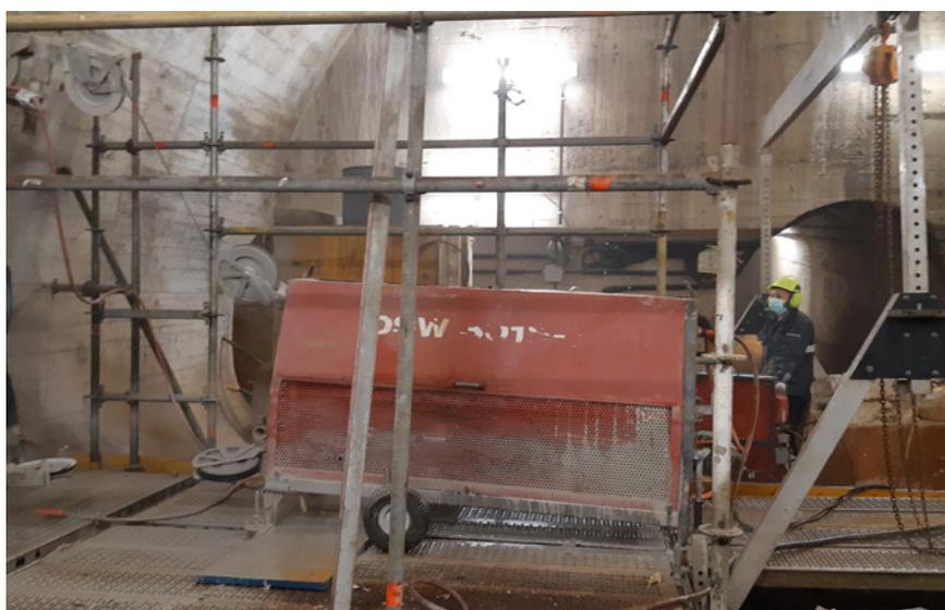
Equipo de hilo Hilti DSW 3018 cortando la pared de una galería a 16,5m de profundidad.
