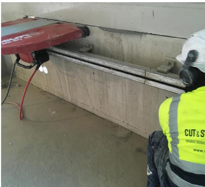
Cortamuros Hilti DST 20-CA cortando un muro de hormigón armado prefabricado.
