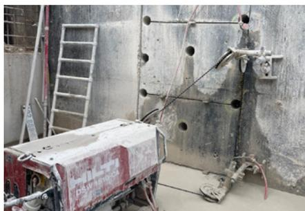
Equipo eléctrico DSW 1510 cortando un muro de hormigón armado.
