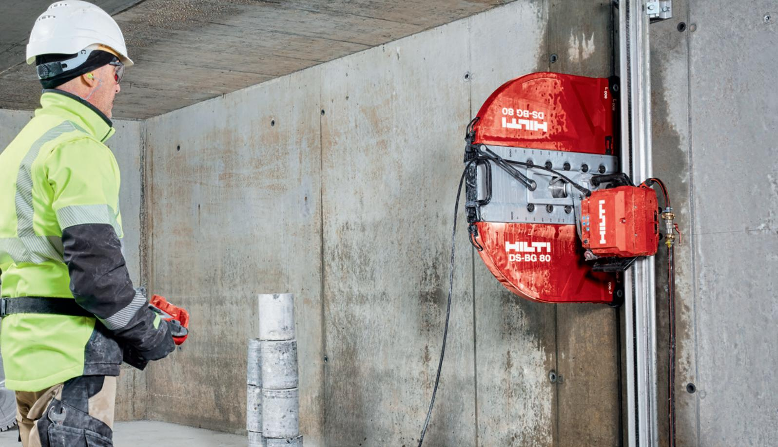
Menos cables, solo agua y luz, no hay una unidad de potencia separada. Diseño de la cabeza de corte perfectamente ergonómica. Montaje y desmontaje del cortamuros fácil y rápido.
