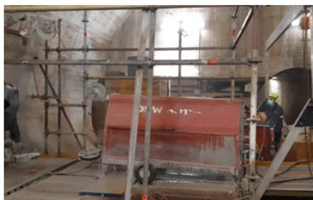
Equipo eléctrico DSW 3018 cortando en una presa.
