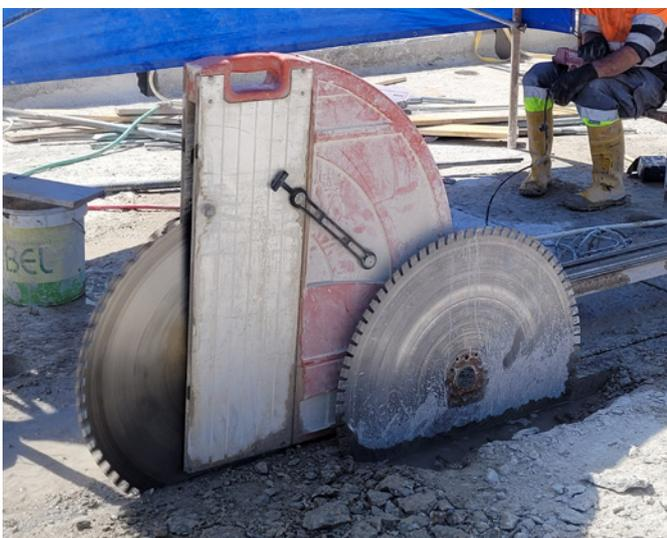
Corte con el cortamuros eléctrico Hilti DS TS 20-E en los peines del puente.
