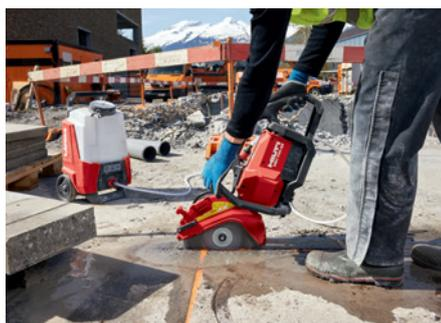
Corte de hormigón con la cortadora a batería DSH 700-22 con el depósito de agua a batería DWP 15-22.
