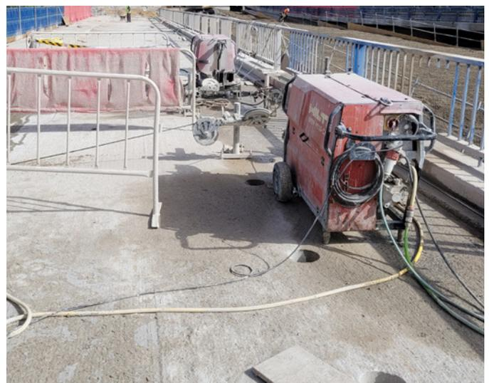
Corte del tablero con el equipo eléctrico Hilti DSW 1510 de 16kW y tracción neumática.
