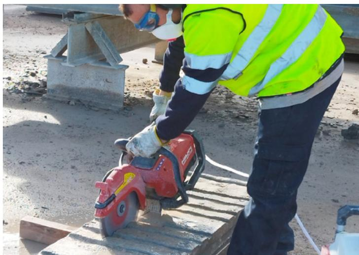
El corte con el depósito de agua Hilti DWP 15-22 de 15l usa la misma batería que la cortadora y evita la emisión de polvo.
