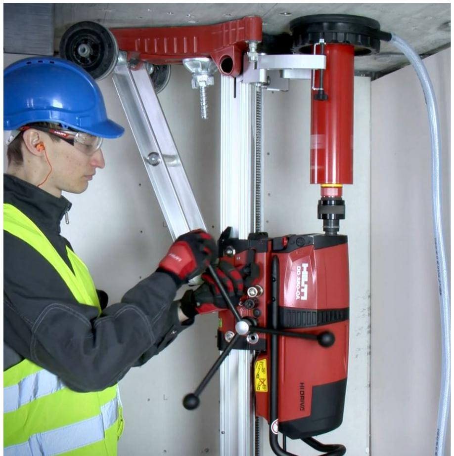
El sistema de estanqueidad Hilti consta de un colector de agua con una junta del diámetro de la broca sujetado a la columna mediante una pieza de retención y conectado a un aspirador.
