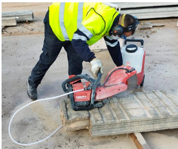
La cortadora a batería DSH 600-22 tiene un peso similar a la cortadora de gasolina equivalente.
