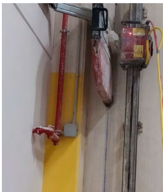
Corte con el cortamuros eléctrico Hilti DST 20-CA en el nivel superior del muro.
