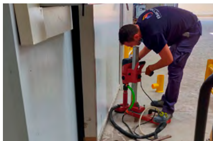
La DD 120 taladrando con la unidad de reciclado de agua.
