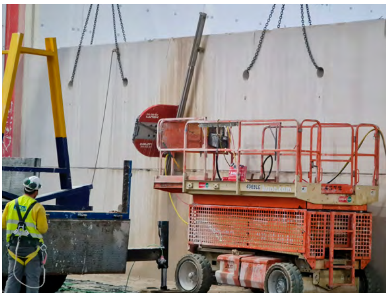
Corte de piezas grandes en el nivel inferior del muro.
