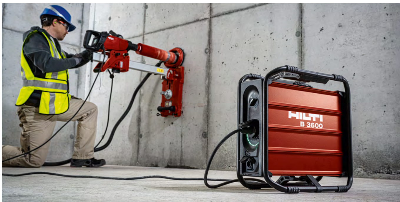
La perforadora de diamante Hilti DD 150 con unidad de reciclado de agua taladrando con la batería móvil Hilti B3600. Trabajo independiente de luz y agua.
