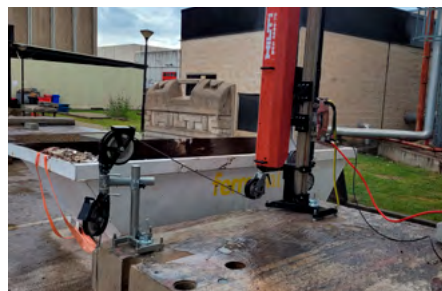
Corte largo con ayuda de una polea pivotante independiente.
