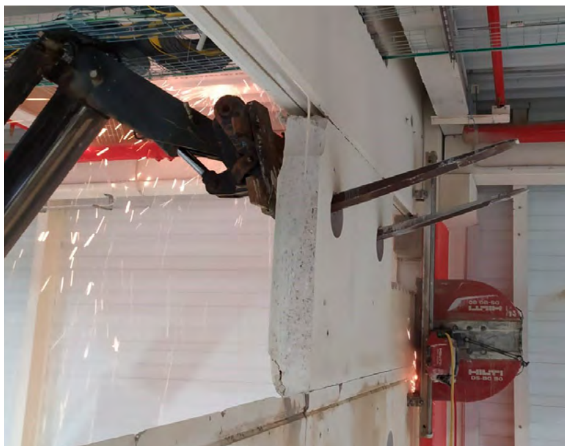
Estrobo de pieza cortada en el nivel superior del muro.
