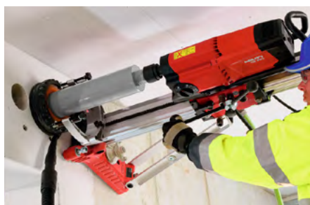
El taladro con brocas grises es óptimo en zonas con hormigones duros y abrasivos.
