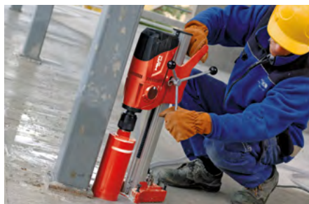
La DD 120 puede taladrar hasta 162 mm de diámetro en hormigón armado.
