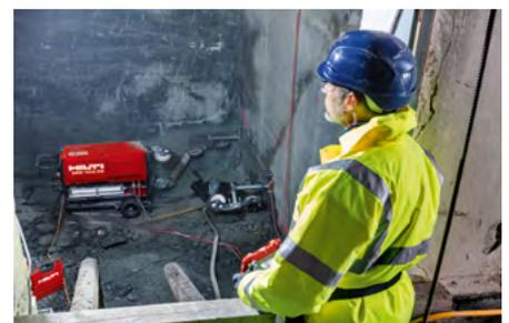
El primer equipo de hilo del mercado en controlarse con un telemando por radio con corte asistido.
