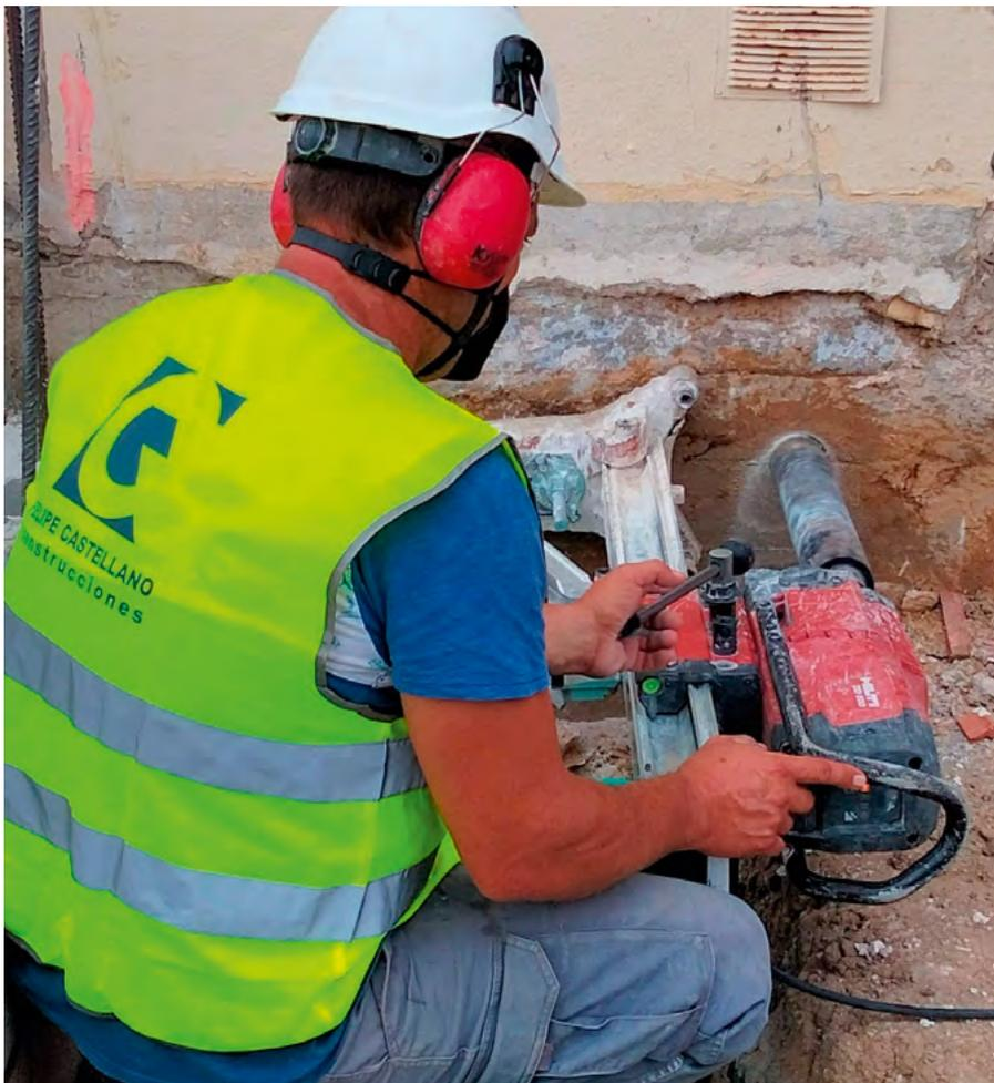
Las perforadoras orientan al operario en la presión con un sistema de luces en el motor.
