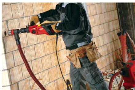
Perforación a través de agujeros en ladrillo para tuberías y conductos (37 a 162 mm de diámetro) con la DD 110 en seco y el aspirador VC 20.
