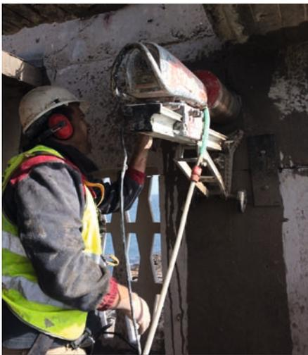
Taladros para embragar las piezas a retirar con la perforadora de diamante Hilti DD 350 de alta frecuencia.
