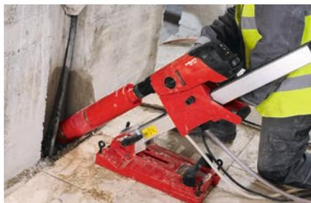
Perforación en ángulo y anclaje con bomba de vacío.
