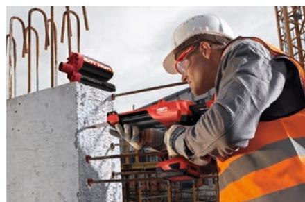
Inyección de resina con el dispensador Hilti a batería HDE 500-A22. También se dispone del sencillo dispensador manual HDM y del neumático P 8000 D para grandes volúmenes.
