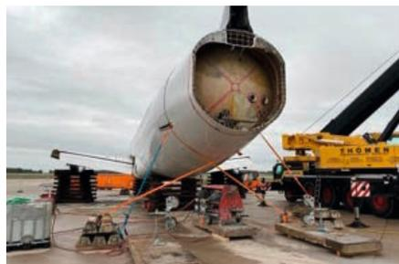
Corte de aviones con hilo de diamante con agua para reciclaje.
