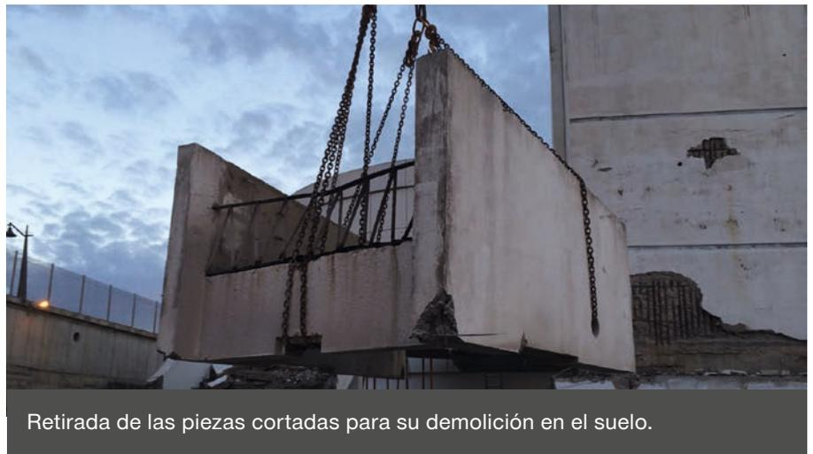
Retirada de las piezas cortadas para su demolición en el suelo.
