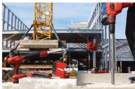
El taladro con broca hueca, que aspira el polvo a la vez, asegura las cargas y acelera enormemente el proceso de colocación de barras.
