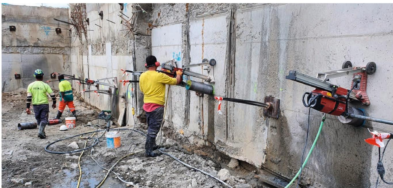
Taladros de 200mm de diámetro sobre el muro de carga muy armado con inclinación 15-30°.
