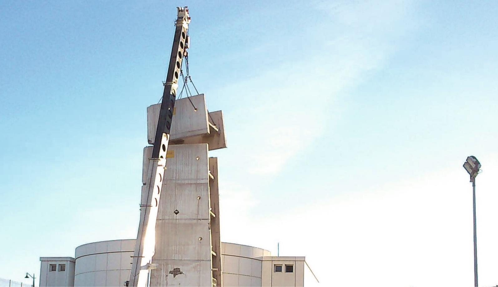
trasera y las laterales se tuvo que usar un disco de 1200 mm de diámetro para alcanzar la profundidad requerida. Para evitar que el disco quedara aprisionado por el peso de la pieza cortada, Perforaciones Costa Tropical fabricó chapas de acero con el grosor del corte para ir las metiendo en la ranura a medida que se iba cortando.
