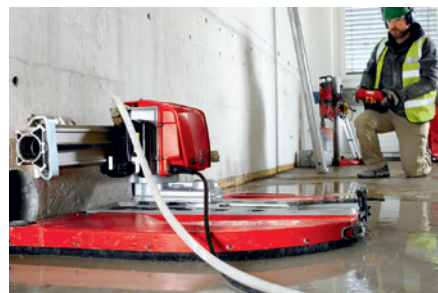
Con el DST 10-CA para la mayoría de los trabajos sólo se precisa un operario.
