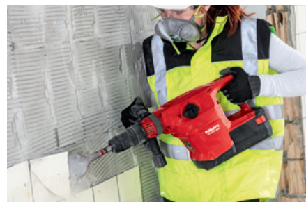
Cincelado ligero y retirada de azulejos en rehabilitación.
