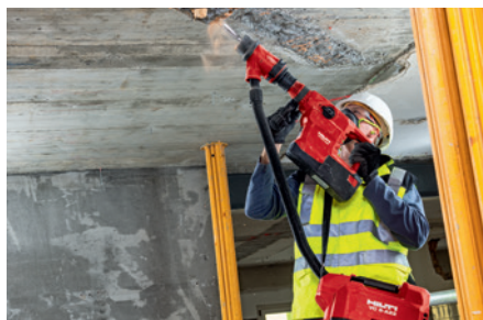
Demolición ligera con rompedor TE 500-A36 con batería de 36V y aspirador VC 5 con batería de 22V.
