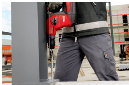
Perforación con martillo combinado TE 30-A36 con batería de 36V.
