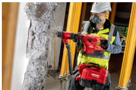
Cincelado de hormigón sin polvo junto al aspirador Hilti portátil VC 5.
