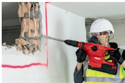
Apertura o ampliación de aberturas en hormigón o ladrillo.
