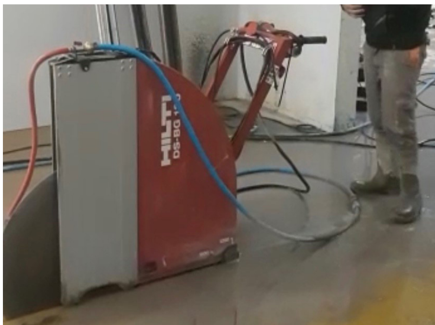
La cortamuros DST 10-CA puede cortar sobre un carro cortasuelos, útil para cortes largos a suelo ahorrándose colocar carriles.
