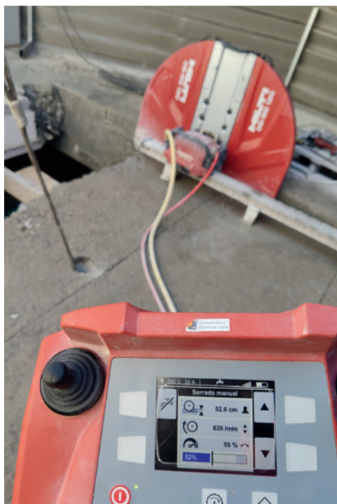
Salamanca de Asistencia usó el cortamuros Hilti DST 20-CA por potencia y ligereza.
