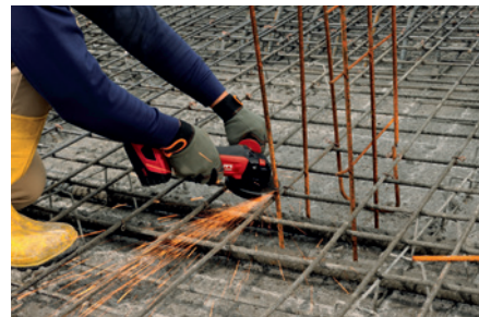
Corte de corrugados con amoladora de 125mm con batería de 22V.
