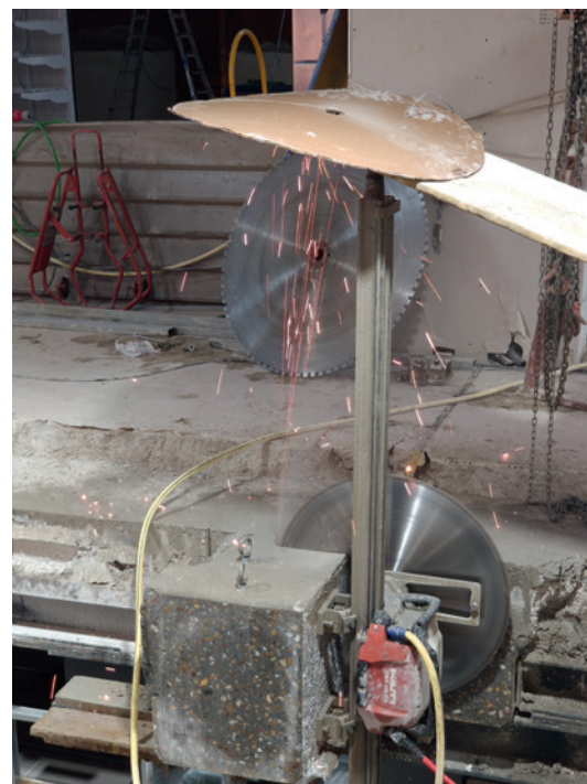
La cortamuros DST 20-CA consta sólo de un potente cabezal de corte y un mando por radio con Cut Assist, corte programado sin intervención del operario.
