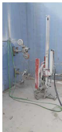
Corte de puertas, ventanas y pequeñas aberturas.
