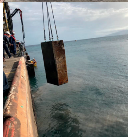
Retirada de las defensas de hormigón armado recién cortadas con grúa.
