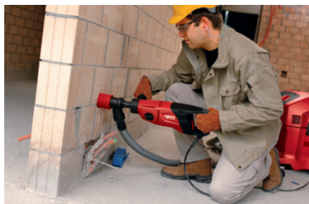
Perforación a través de agujeros en ladrillo para tuberías y conductos (37 a 162 mm de diámetro) con la DD 110 en seco y el aspirador VC 40.
