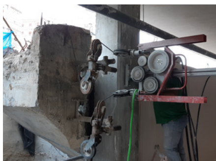
Corte de pilares, forjados y salientes ventanas.
