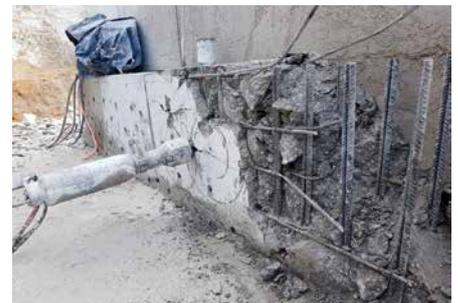
Quebrantamiento del hormigón restante en la zapata con el sistema Darda.
