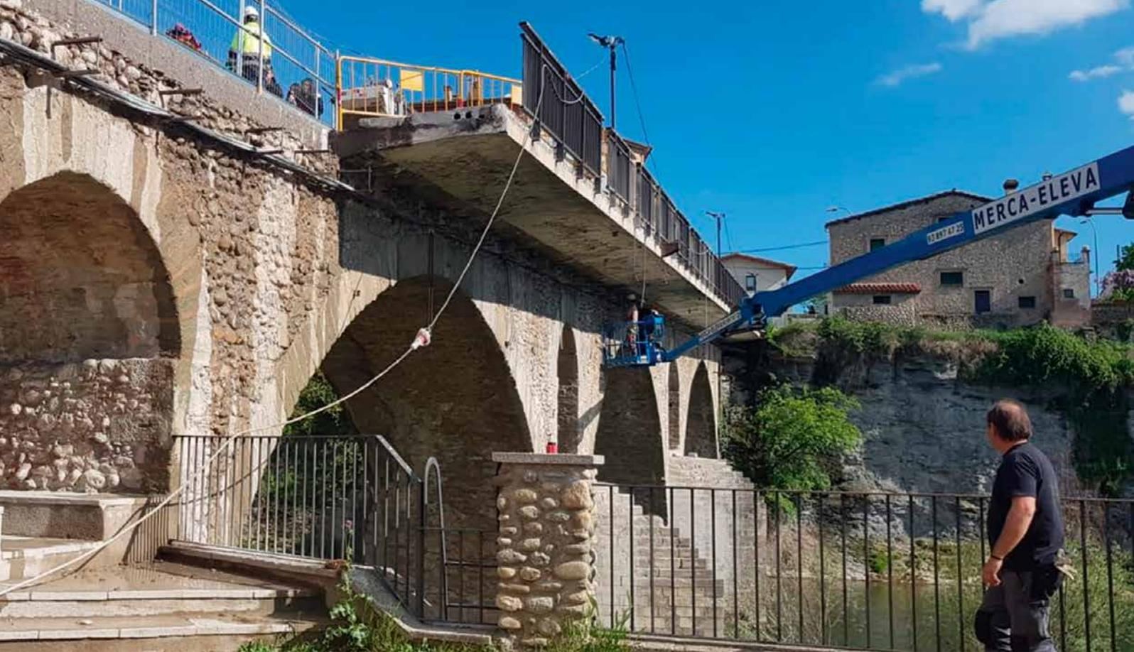
hasta 50 cm y el resto con un equipo de corte con hilo diamantado hasta 60-70 cm. Los cortes transversales con un potente cortamuros hidráulico de disco Hilti D-LP 32.
