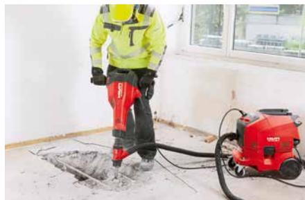
El TE 2000-AVR es la herramienta con la mejor proporción potencia/peso. El sistema de aspiración TE DRS-B recoge hasta el 95% del polvo.
