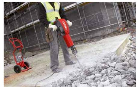
El TE 3000-AVR puede sustituir a las perforadoras neumáticas gracias a su excepcional potencia.
