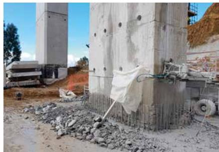
El hormigón en masa al descubierto fue cortado con un equipo de hilo diamantado.
