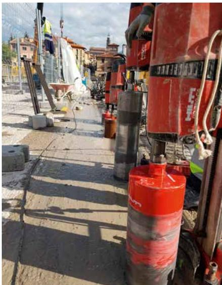
Las perforadoras Hilti DD 350 y DD 500 de alta frecuencia ofrecen una gran potencia y fiabilidad.
