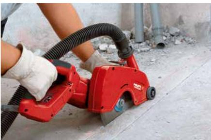
La cortadora se desplaza sobre las ruedas delanteras facilitando el corte.
