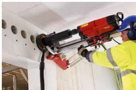
Pasantes de varias dimensiones para tuberías y conductos con recogida de agua.
