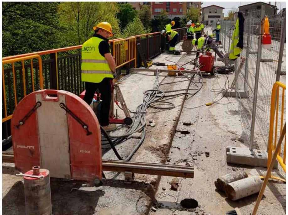
Corte de las piezas con el cortamuros de disco Hilti D-LP 32 de alta potencia.
