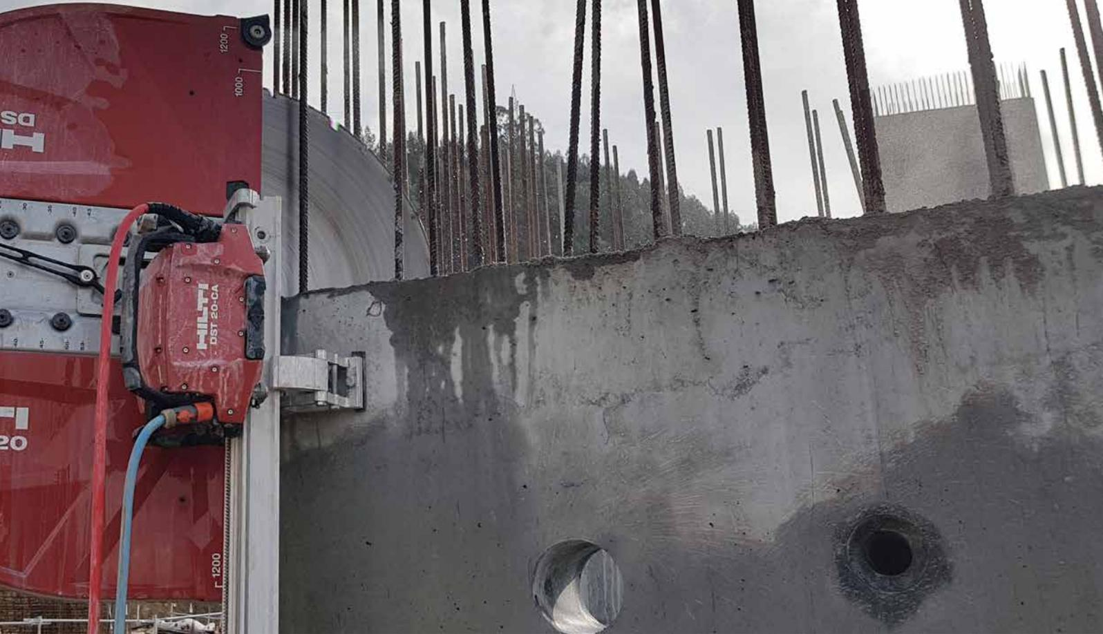
Tras ello se cortó el relleno con un equipo de hilo diamantado taladrando sucesivamente agujeros para retirar las piezas con la grúa, en total 10 bloques.
