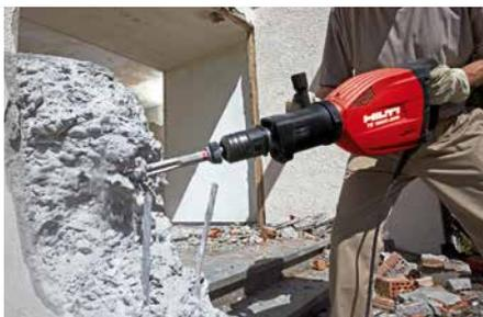
El TE 1000-AVR puede cincelar con gran potencia a suelo y a pared hasta la cintura. El sistema AVR mantiene las vibraciones al mínimo.
