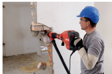
El sistema de aspiración TE DRS-B recoge hasta el 95% del polvo.
