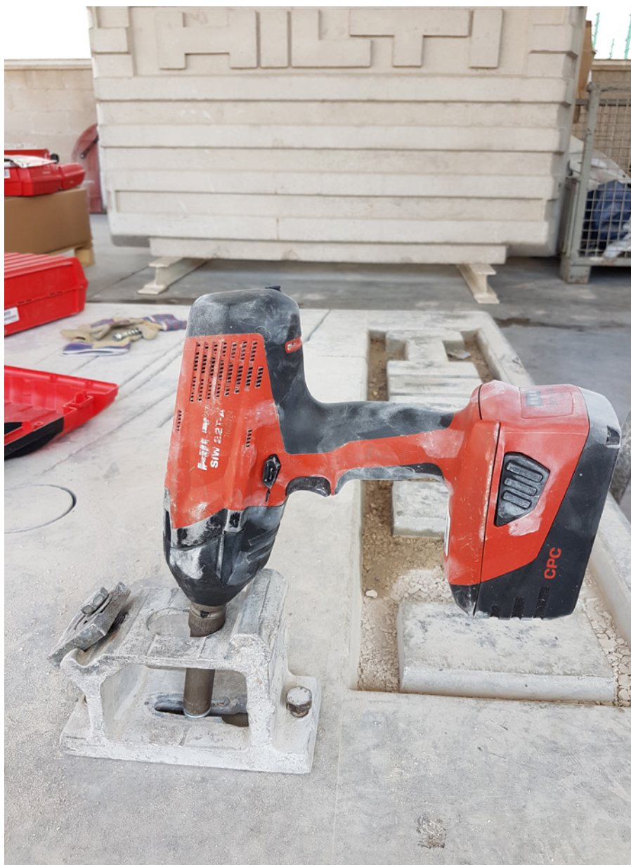
Anclaje de un soporte de carril de un equipo de corte mural con un anclaje de tornillo HUS3-H 10x100 con la atornilladora Hilti de impacto SIW 22T-A con vaso largo.
