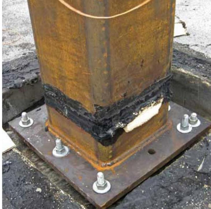
**Figura 4:** Los detalles de plano deben establecer límites en la forma en que se ajustan las ubicaciones de los anclajes. En este caso, fue necesario realizar una segunda perforación (y también un nuevo taladro en la placa base) porque en la posición inicial la broca encontró armado y no pudo seguir. Sin embargo, resistencia de la unión se ve reducida porque la separación entre anclajes es demasiado pequeña.
