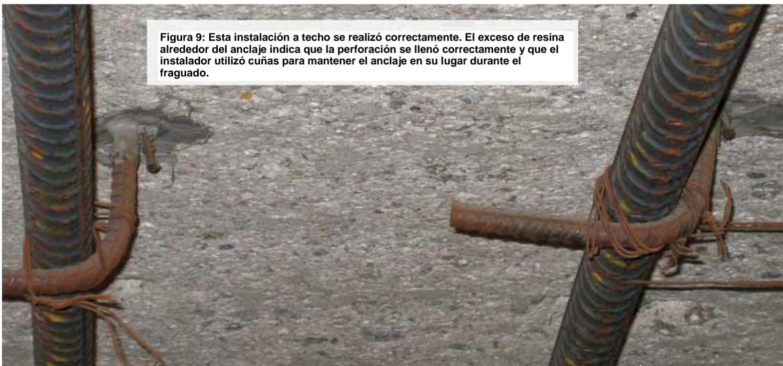
**Figura 9: Esta instalación a techo se realizó correctamente. El exceso de resina alrededor del anclaje indica que la perforación se llenó correctamente y que el instalador utilizó cuñas para mantener el anclaje en su lugar durante el fraguado.**
