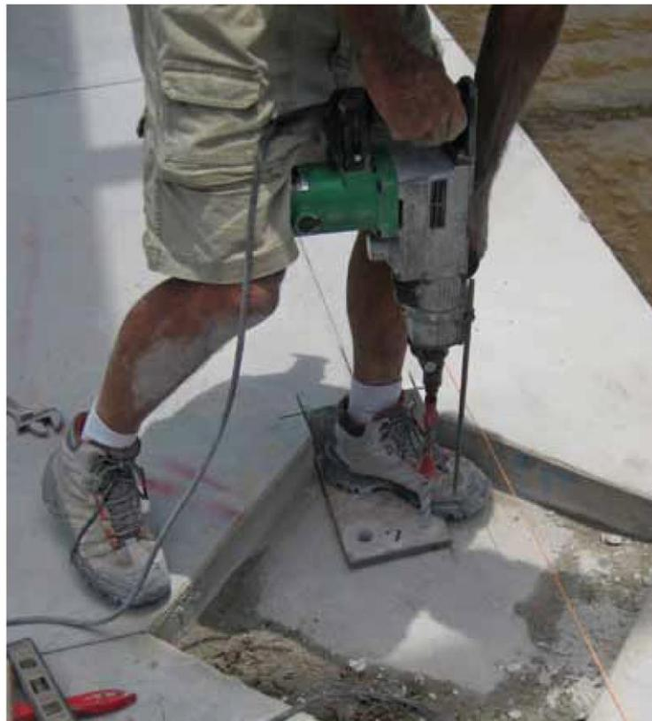
**Figura 6:** Método correcto para taladrar. El instalador está perforando a través de una plantilla utilizando un martillo r con tope de profundidad.
