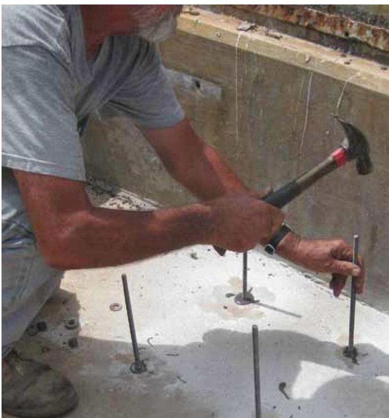
**Figura 5:** Después de inyectar la resina, hubo que meter a martillazos estas varillas roscadas porque el diámetro del taladro era demasiado pequeño. El tamaño de la broca requerido para un diámetro de anclaje dado se debe establecer claramente en las instrucciones del fabricante
