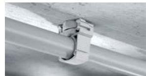
Cable conduits or light-duty pipes
