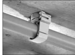
Cable conduits or light duty pipes
