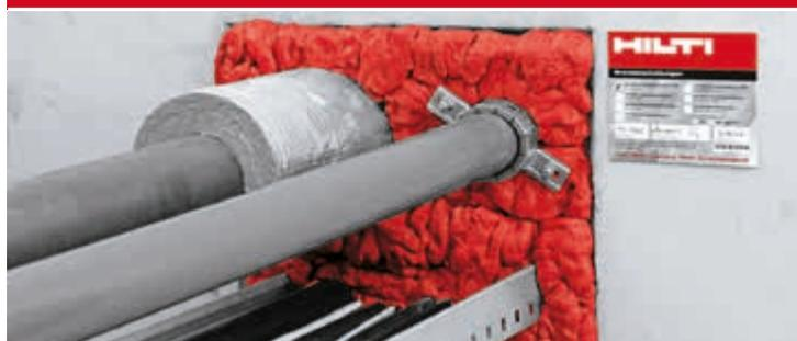
Soluciones para pasos de instalaciones a través de muros o forjados, y juntas de sellado y estanqueidad frente al fuego para minimizar daños tras el terremoto.
