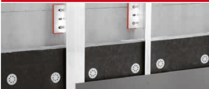
Estructuras auxiliares de aluminio para sistemas de fachadas ventiladas ligeras, sistema testado para aplicaciones sísmicas.
